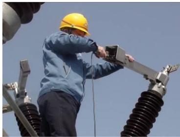
第三步 测量触指压力
