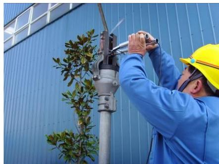
第三步 测量触指压力(已挂静触头, 使测量头宽度略大于 a) 的测量
